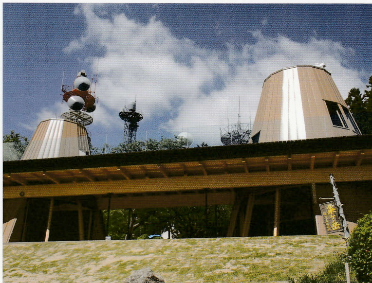
かっぱし型のスカイテラスとフジテラス及び水平デッキ屋根
