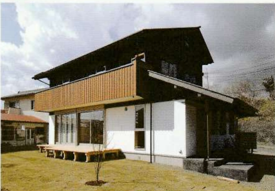
ベランダ、デッキ、玄関戸、板塀、軒裏など、外回りにも木を多用。
