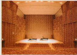
ヒノキのリブ(部材)を巡らせた壁と、スギ材の椅子。
