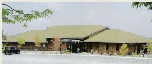
周囲の自然と調和する芝張りの屋根と木の外壁
