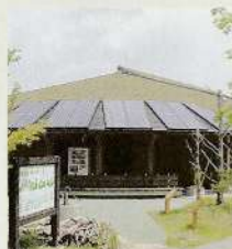
屋根に設置された太陽光発電のパネル
