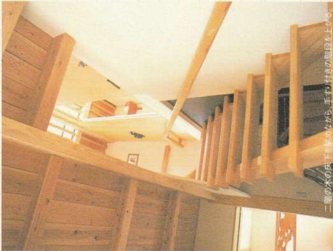
壁は味のある風合いのしらす漆喰。スギの天井には穀本の梁（はり）が走り美しい構造美を見せている。
