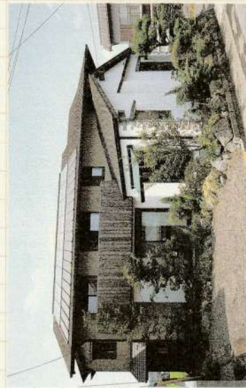
正面が南向きになるように建物を配置した山崎邸の外観。ベランダの外装には木が使われており、手前の白壁の家屋があつ子さんの家庭料理のお店。
