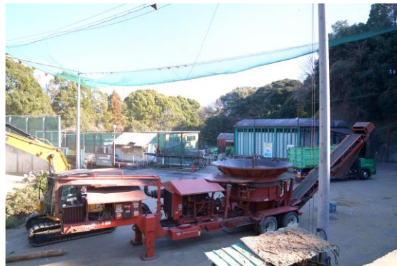
リサイクルセンターで稼働している大型の破砕機
