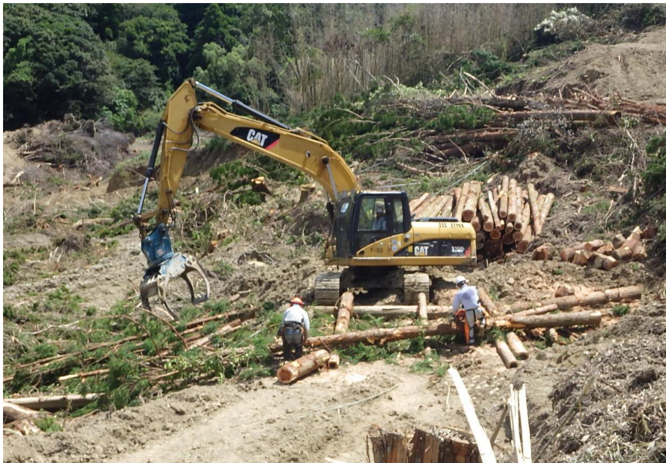
伐採工事の現場
