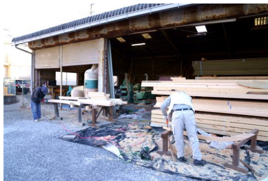
敷地内にある大工の作業場
