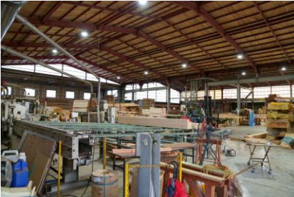
工場の天井を断熱構造に改修
