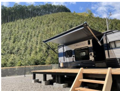
山林の多面的な活用を目指したキャンプ場の設計・施工
