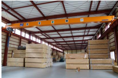
スケールの大きな鉄骨の加工場
