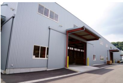
国産材複合梁を用いた加工場 外観
