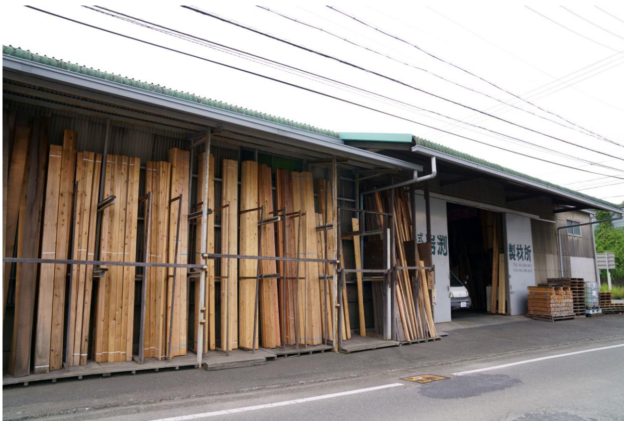
第一倉庫と工場
