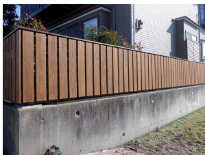
外構工事による住宅のウッドフェンス
