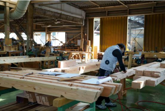
社員大工による手刻みの作業場
