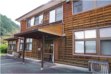
下見板張りの外壁仕上げの事務所棟
