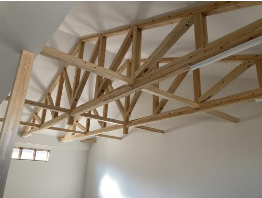
技術的な提案により実現したトラス架構
