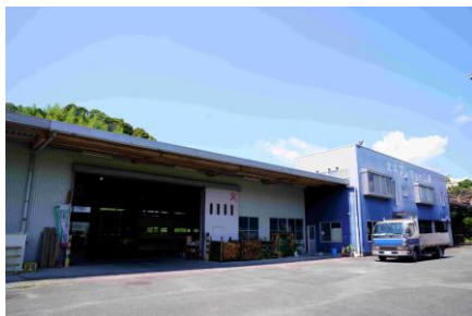
倉庫(手前)とオフィス棟
