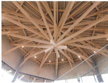
木架構(2階から)
