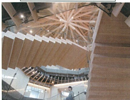
1階から天井を見上げる
