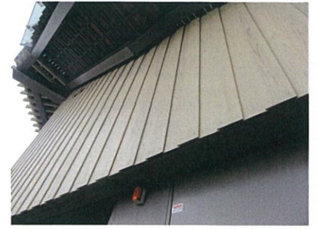
外壁（スギ板張り）
