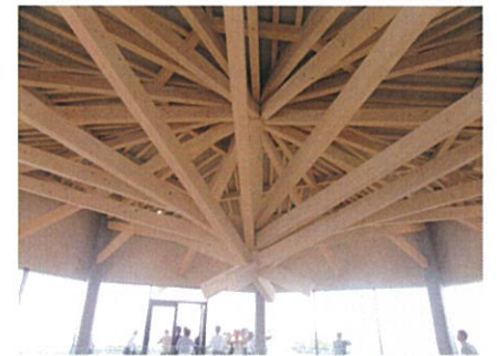
木架構(3階から)
